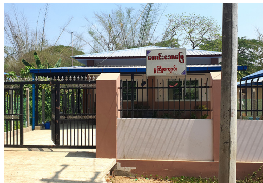
신축 유치원 전경 |
